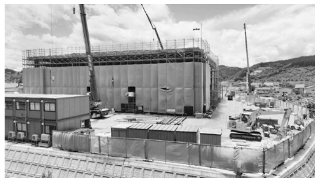
建設中の役場新庁舎
