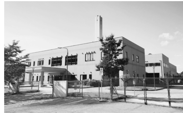
エコプラザもがみ (可燃物処理施設)
