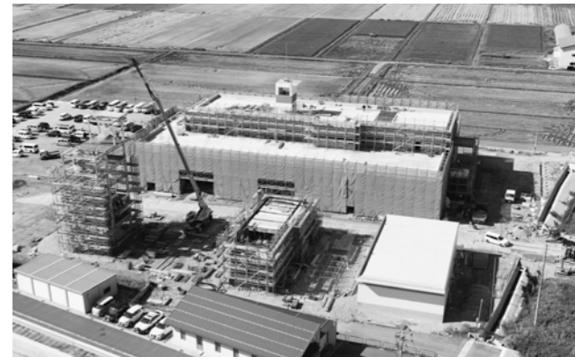
建設中の新消防庁舎
