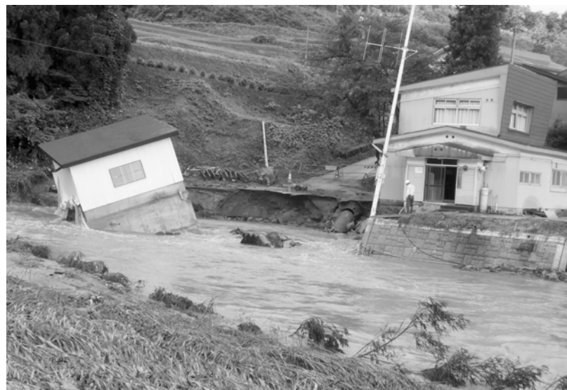
台風被害を受けた平林地区
