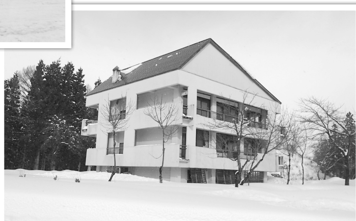
克雪管理センター
