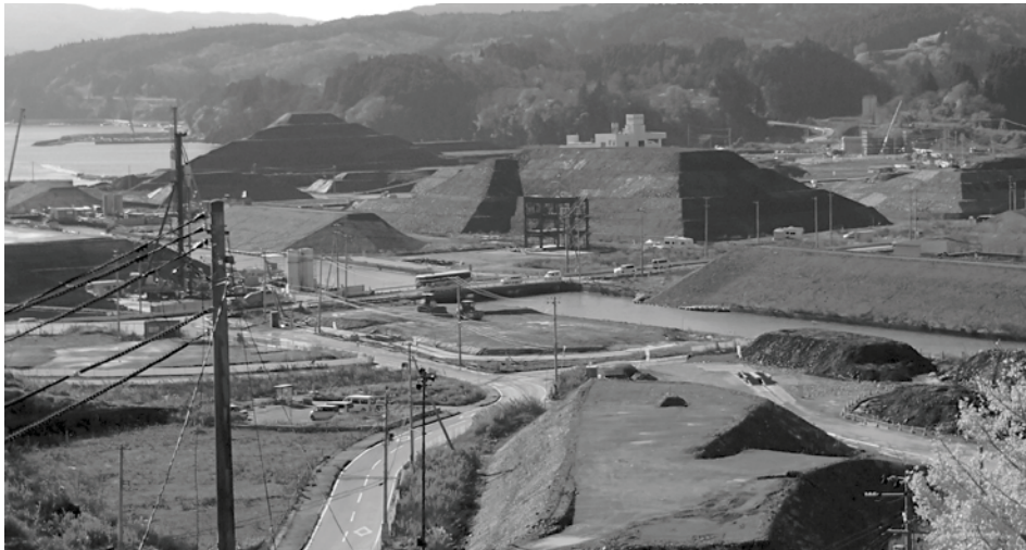
復興が進む南三陸町、被災した防災庁舎が隠れる程の盛土
