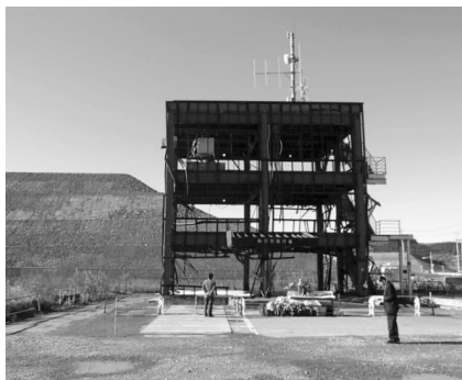
防災センター
