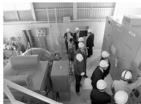
四時ダム発電所内部
