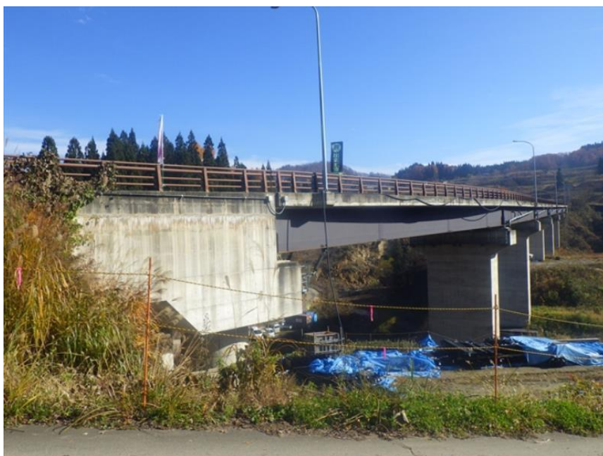
滝の沢大橋（市町村道 土合・滝ノ沢線 平成15年架設）
