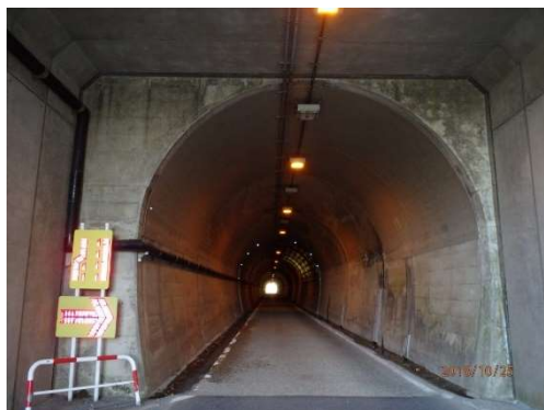
起点側坑口（坑門は一部のみ露出） （※ボックス内より撮影）
