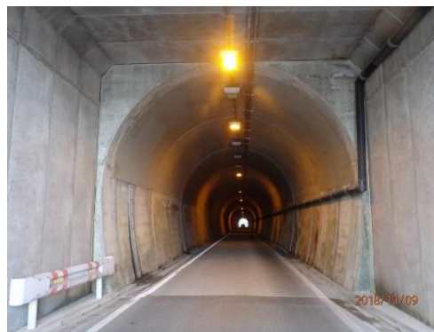
終点側道路状況（坑門は一部のみ露出） （※ボックス内より撮影）
