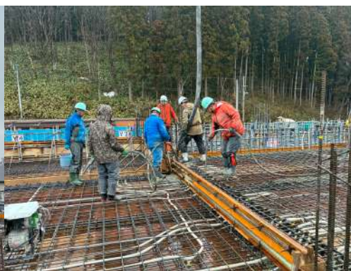
柱・梁打設状況
