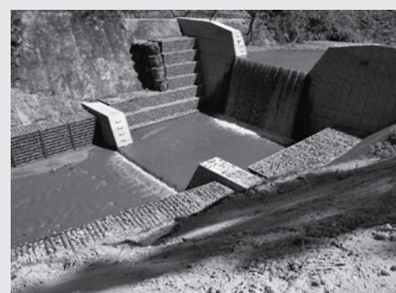
▲昨年度に施工した古水川のダム
