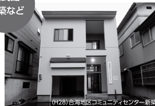
(H28)台海地区コミュニティセンター新築
