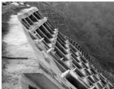
▲ 法枠工に設置されたアンカー工 (H26完成 寒風田法枠工)
