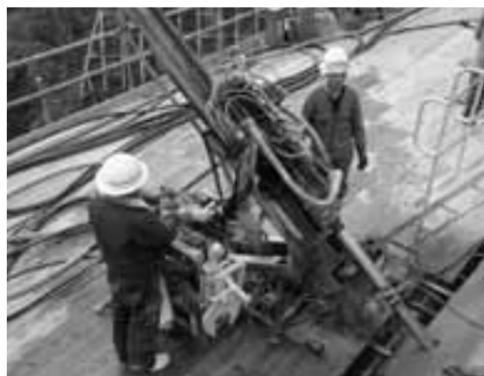
▲ アンカー工の施工状況(機械による削孔)
