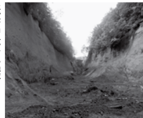
▲西松沢 NO.5鋼製杵谷止工 設置前
