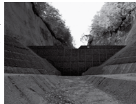
▲西松沢 NO.5鋼製杵谷止工 設置後
