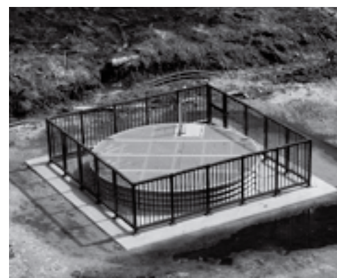
▲平成26年度完成の寒風田地区No4集水井（深さ109m）
