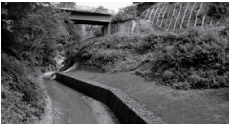
第8号古水川鋼製枠護岸工 平成28年度施工
