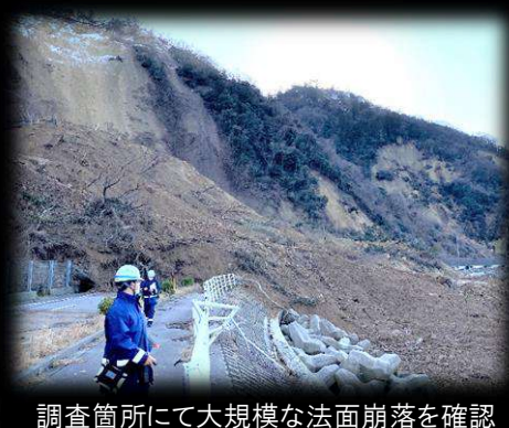
調査箇所にて大規模な法面崩落を確認
