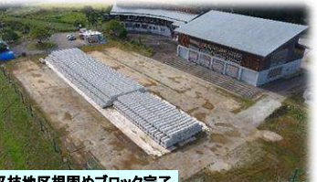
平枝地区根固めブロック完了
