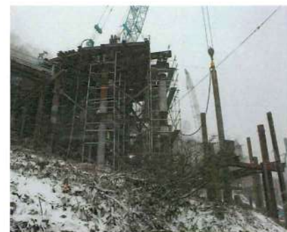
ダウンザホールハンマー工施工状況
