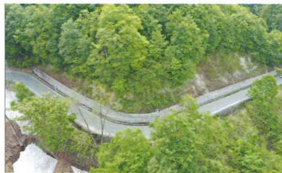
1工区 着工前5月撮影
