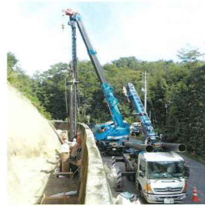
ダウンザホールハンマー工施工状況
