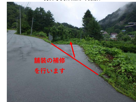
現況写真(終点より撮影)
