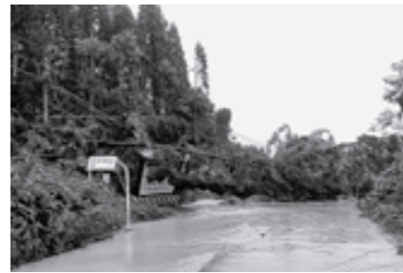
▲H25.7 土砂崩れにより通行止めになった稲沢地区入口付近(県道大石田畑線)
