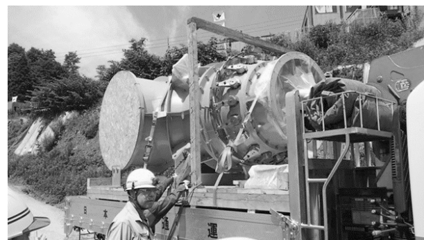
建設中の升玉小水力発電(水車)
